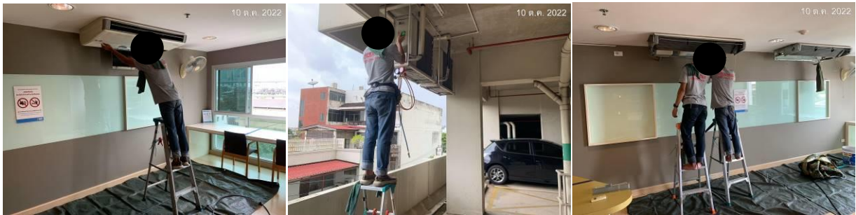
รูปที่ 2-34 ล้างเครื่องปรับอากาศพื้นที่ส่วนกลาง
