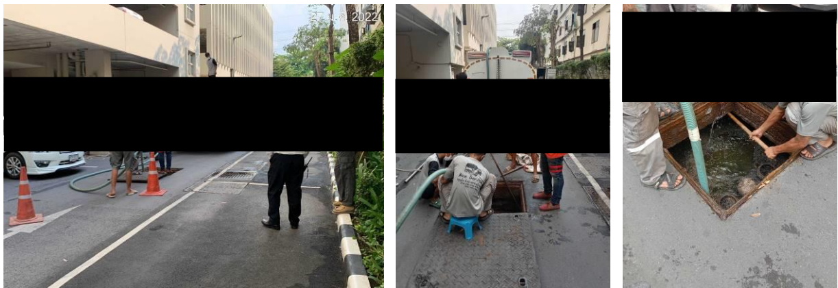
รูปที่ 2-26 สูบไขมันและสูบล้างท่อส่วนเกินเมื่อวันที่ 27 มกราคม 2565
